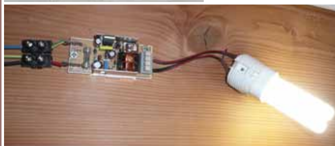
Toujours à la maison de l'auteur. Éclairage 24 V continu. Le ballast électronique et les fils alimentant la fluo compacte gagneraient à être blindés...
